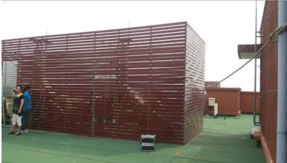
图 6-5 项目现有排气筒位置
