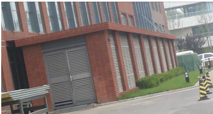
图 6-11 项目南侧设备区
