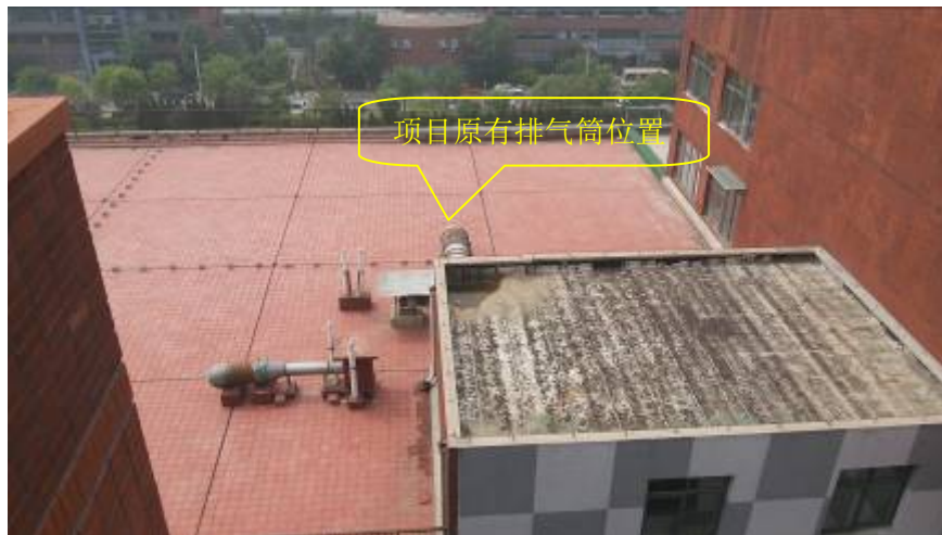
图 6-4 项目原有排气筒位置
