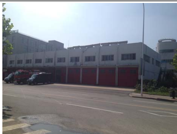
南侧: 北京消防教育训练中心 (拍摄方向: 自北向南)
