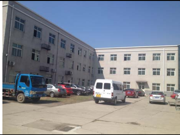
院内意安大厦西南侧办公楼 (拍摄方向: 自东向西)
