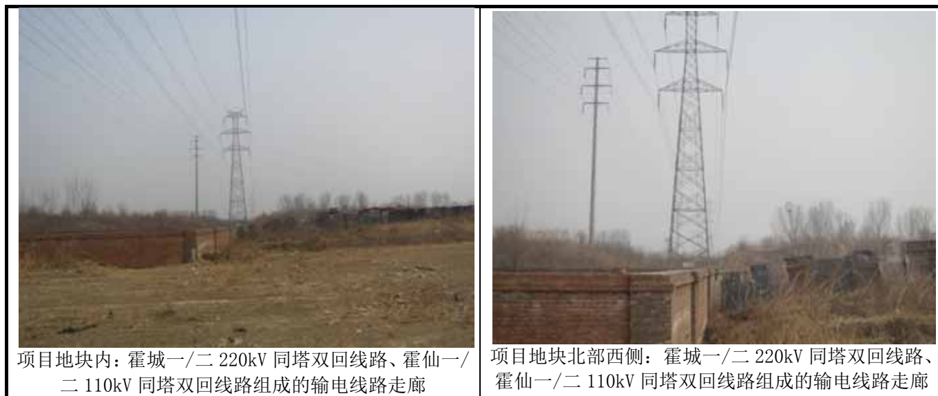
图 5.3-2 项目地块内的输电线路
