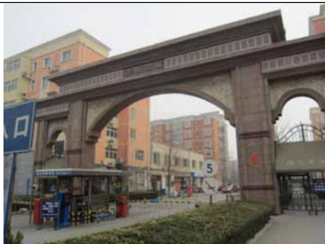
项目东南侧：◆6 望都家园小区（立汤路东侧）
