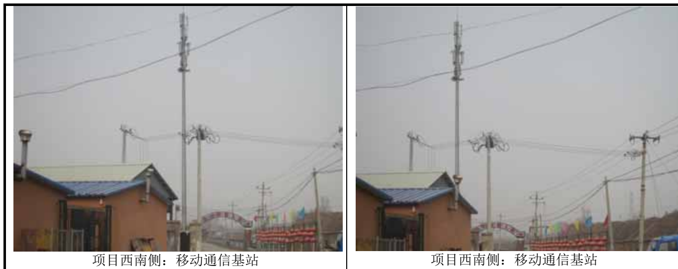
图 5.3-4 项目地块外的移动通信基站
