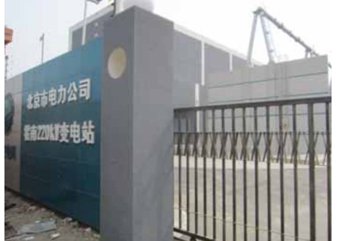
项目西北侧：霍南 220kV 变电站（空地北侧）
