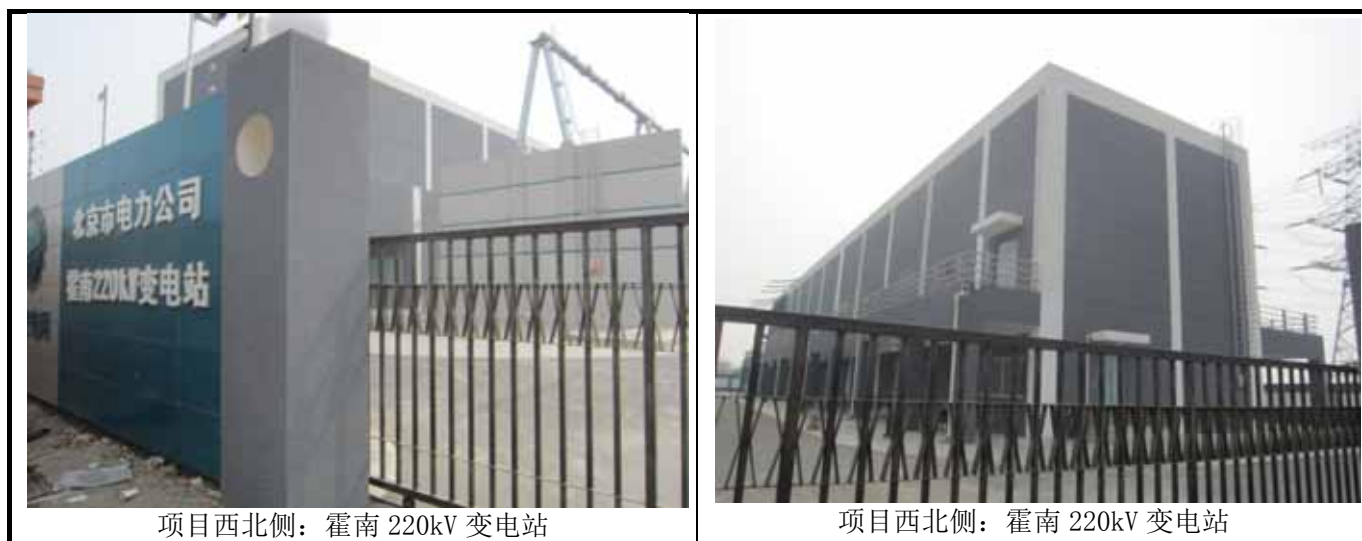
图 5.3-1 霍南 220kV 变电站照片
