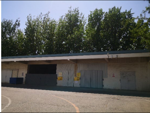
危险废物间外部照片
