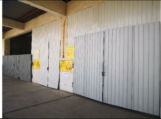
危险废物间外部照片
