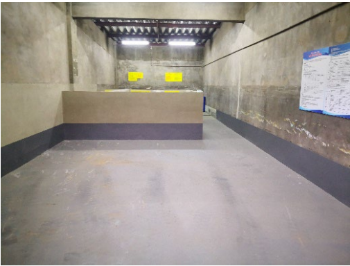
危废间内部地面照片
